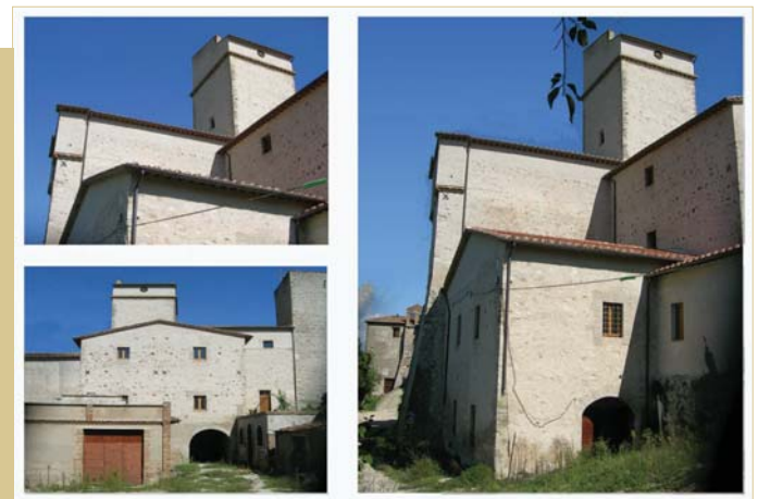
RESTAURO DEL BORGO MEDIEVALE DI GUADAMELLO
