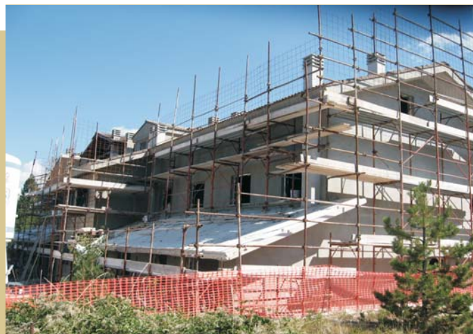
CANTIERE IN LOCALITA' SAMMERIANO - FRONTIGNANO USSITA (MC)
