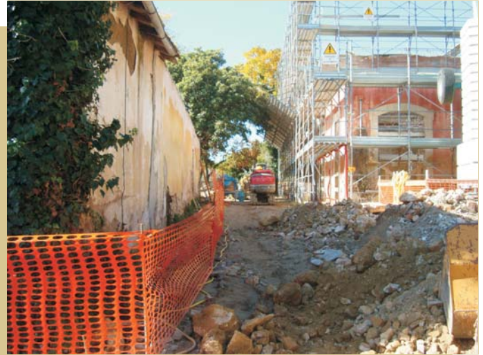
CANTIERE A COLLE DELL'ORO - TERNI
