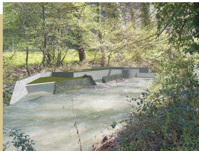
CENTRALI MINI IDROELETTRICHE IN VALNERINA
