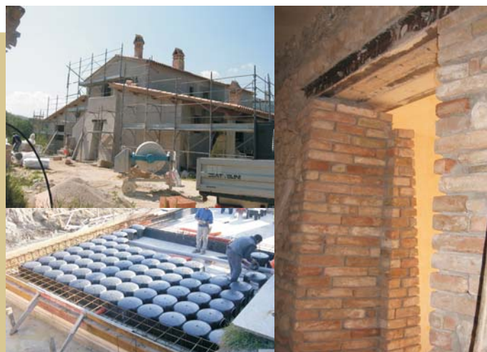
CANTIERE IN STRADA DI CASTELLUCCIO - NARNI
