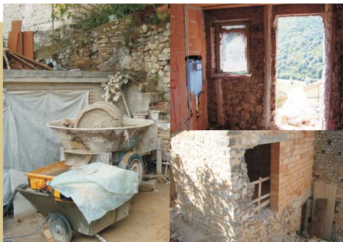
CANTIERE IN LOCALITA' CASTELDILAGO - TERNI
