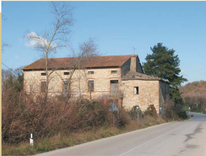
MESSA IN SICUREZZA DELLA "FATTORIA DI PANTALLA" SITO IN TODI (PG), FRAZIONE PANTALLA
