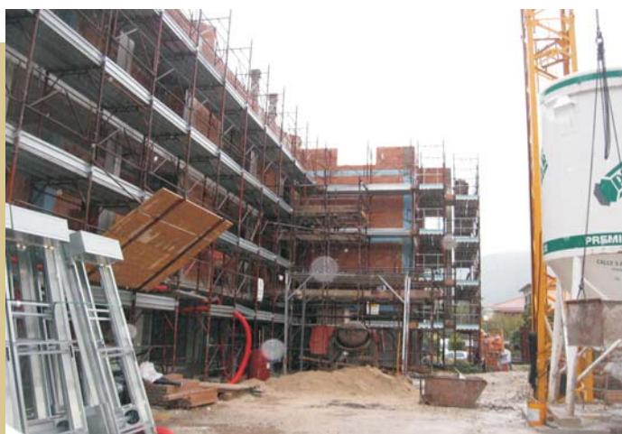
CANTIERE IN VIA MINERVA - NARNI
