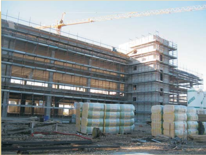
CANTIERE IN VIA BRAMANTE - TERNI
