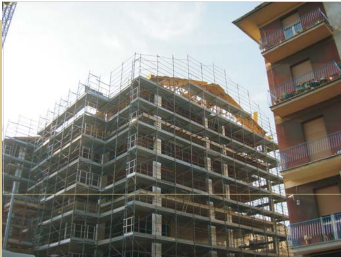
CANTIERE IN VIA VERRI - TERNI
