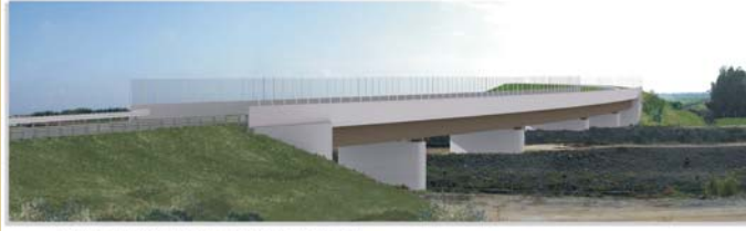
IMMAGINE REFESA PRESSO LLATTRAVESAMENTO DEL RIU MANNU VERSO LA S.S. 196 STATO POST OPERAM
