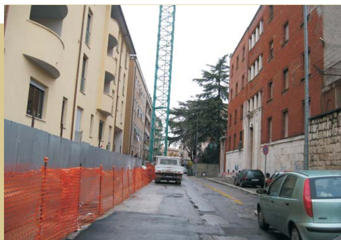
CANTIERE IN VIA ROMAGNOSI - TERNI
