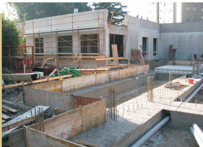
CANTIERE IN LOCALITA' COSPEA - TERNI
