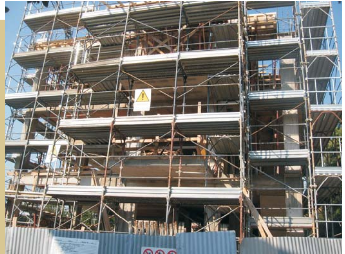
CANTIERE IN VIA TREVÌ - TERNI
