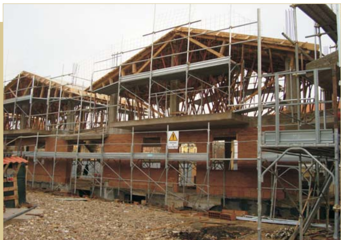
CANTIERE IN LOCALITA' CASTELLINA - TERNI
