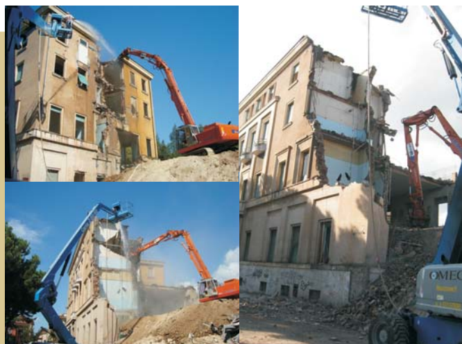
CANTIERE IN VIA SAURO - TERNI
