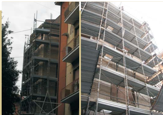
CANTIERE IN VIA NOBILI - TERNI
